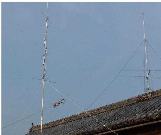
図2. アンテナ外観 (R7, ペットボトル傾斜型, HB9CV)
