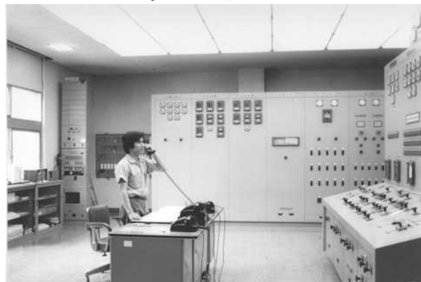
(写真: 制御室にて 左後方は150kHz帯送信機アンテナは送電線? いえ電力線搬送装置です。PLCの元祖?)
